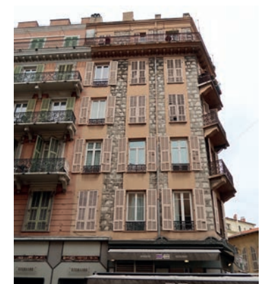
Enduits d'origine supprimés
