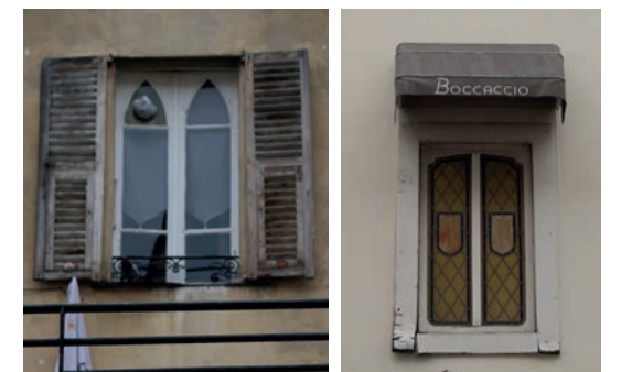
Menuiseries bois d'origine, verres losange mis en plomb
