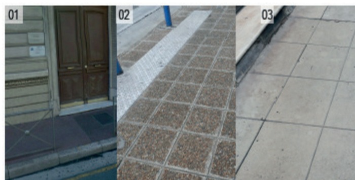
Gradient d'albédo selon différents revêtements (source : EODD)
