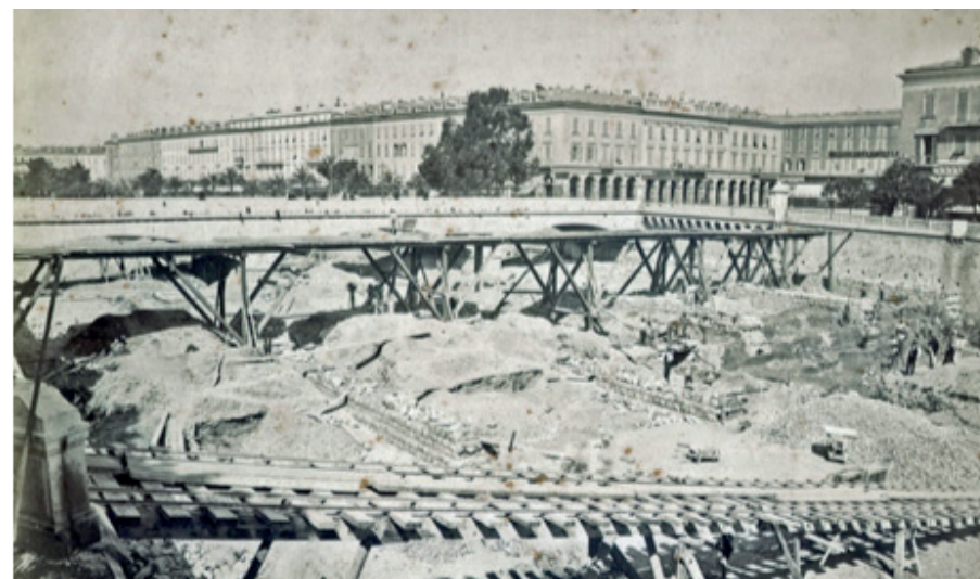
1881 : Travaux de couverture du Paillon
